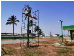
Mejora de instalaciones eléctricas
